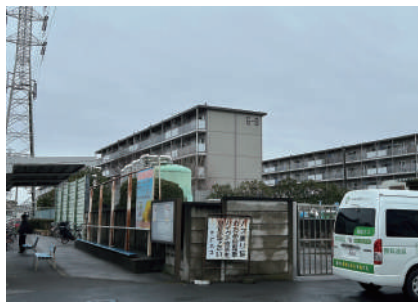
⑤高津団地バス停横 浄水場前
